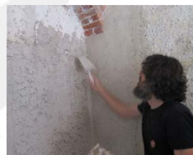
Stratigrafia-tipo per muratura esistente in laterizio o pietra con CALCECANAPA® TERMOINTONACO (spessore 5-10 cm)
